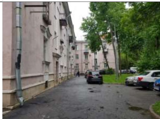
Фото 2. Вид здания, в котором расположен Объект оценки
