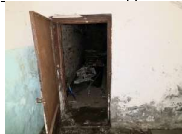
Фото 9. Внутреннее состояние Объекта оценки
