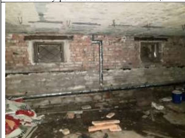
Фото 11. Внутреннее состояние Объекта оценки
