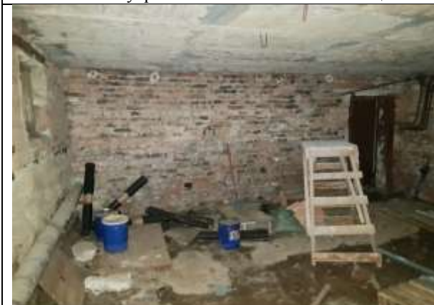
Фото 13. Внутреннее состояние Объекта оценки
