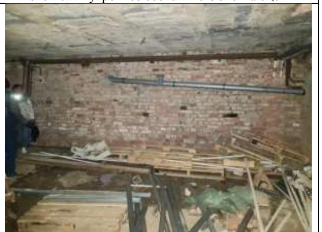
Фото 12. Внутреннее состояние Объекта оценки
