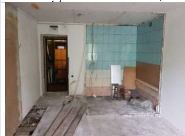
Фото 11. Внутреннее состояние Объекта оценки
