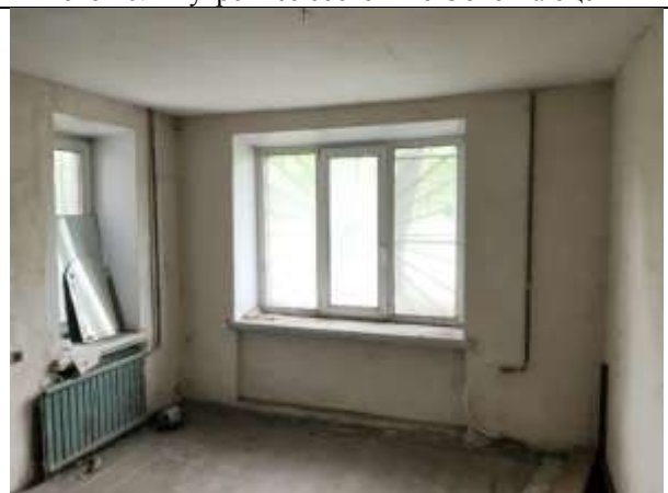
Фото 12. Внутреннее состояние Объекта оценки
