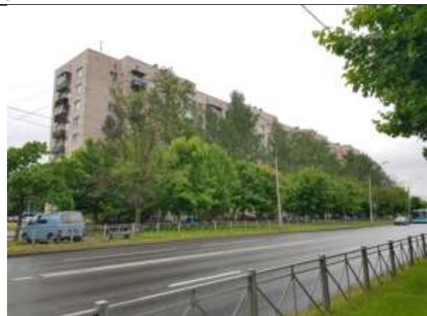
Фото 2. Вид здания, в котором расположен Объект оценки
