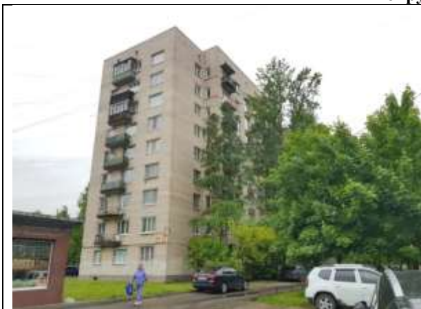
Фото 1. Вид здания, в котором расположен Объект оценки
