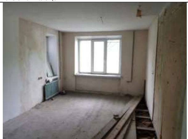
Фото 10. Внутреннее состояние Объекта оценки
