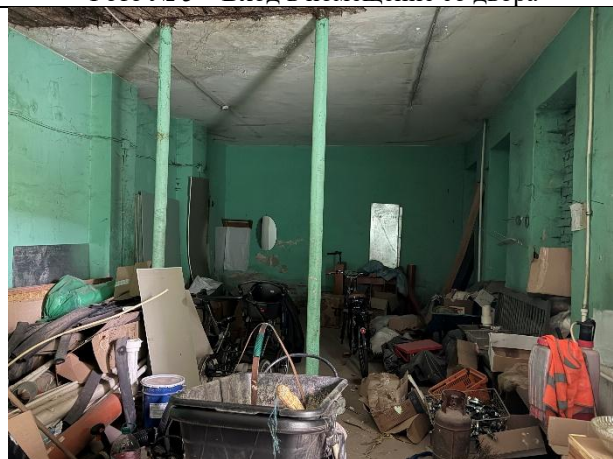
Фото № 7 – Внутреннее состояние помещения
