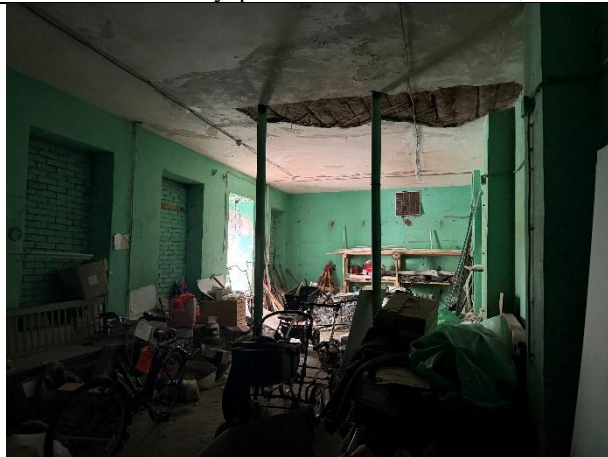
Фото № 11 – Внутреннее состояние помещения
