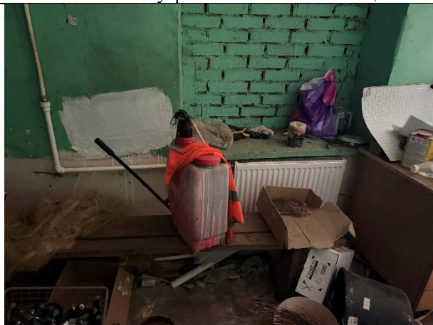
Фото № 13 – Внутреннее состояние помещения
