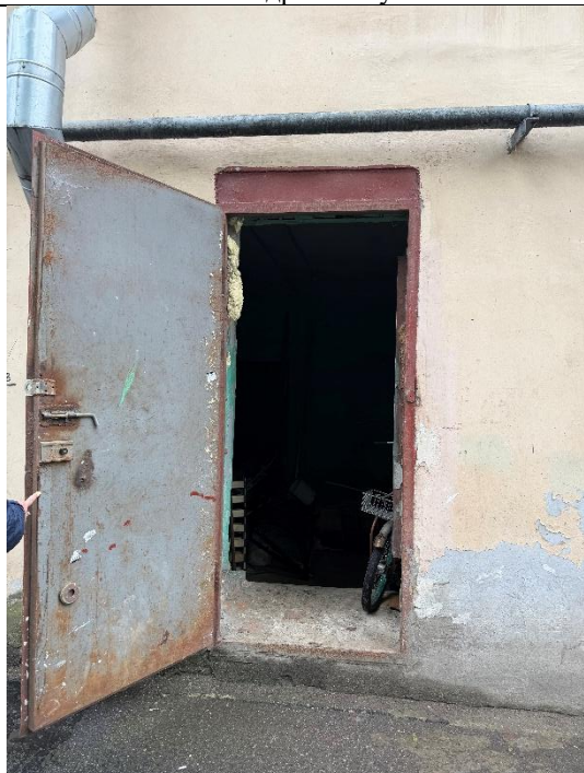
Фото № 5 – Вход в помещение со двора
