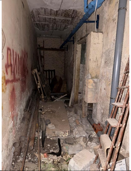
Фото № 10 – Внутреннее состояние помещения
