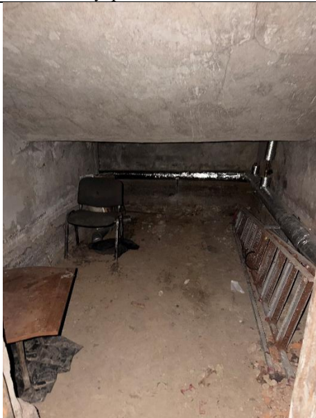
Фото № 11 – Внутреннее состояние помещения
