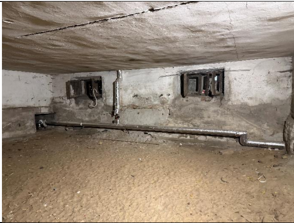
Фото № 9 – Внутреннее состояние помещения
