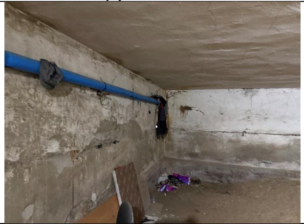
Фото № 10 – Внутреннее состояние помещения
