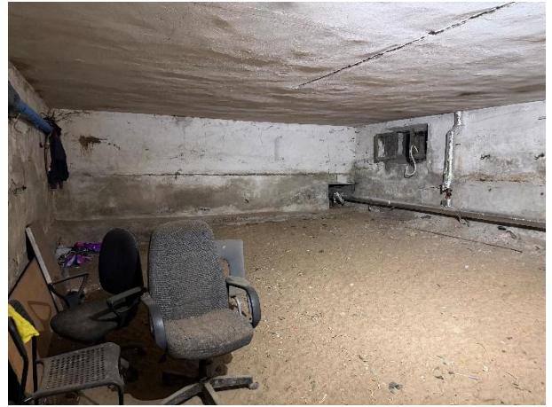
Фото № 8 – Внутреннее состояние помещения
