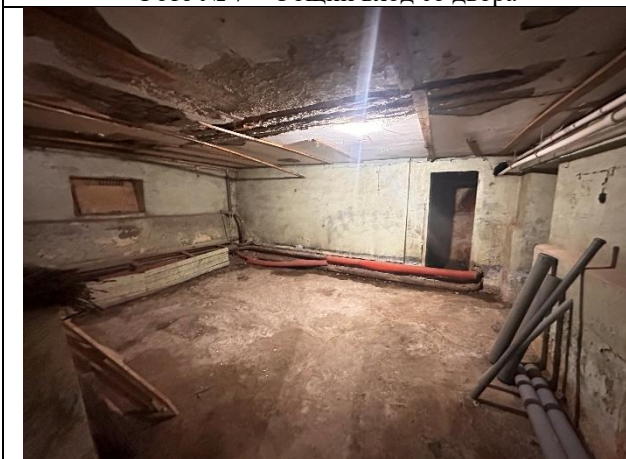
Фото № 9 – Внутреннее состояние помещения
