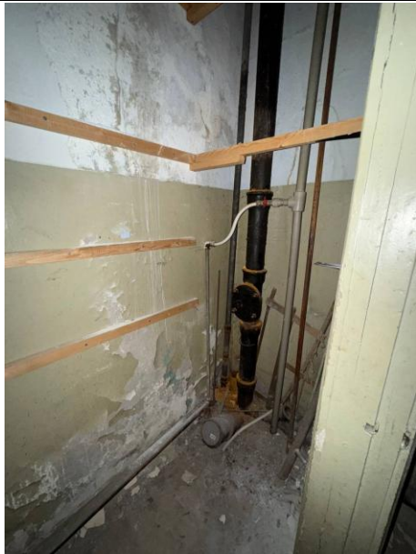
Фото № 11 – Внутреннее состояние помещения
