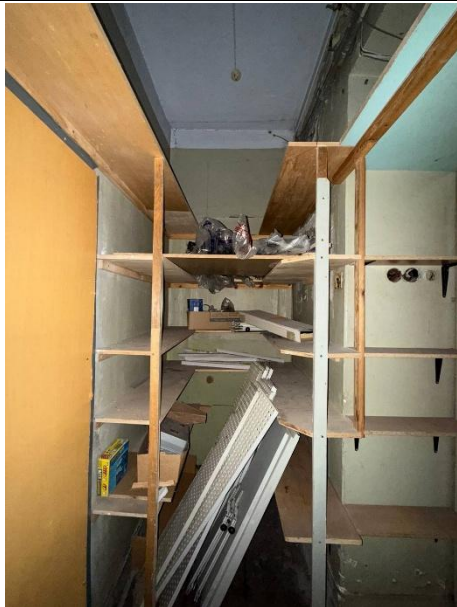
Фото № 13 – Внутреннее состояние помещения
