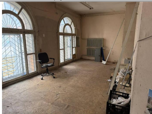
Фото № 7 – Внутреннее состояние помещения
