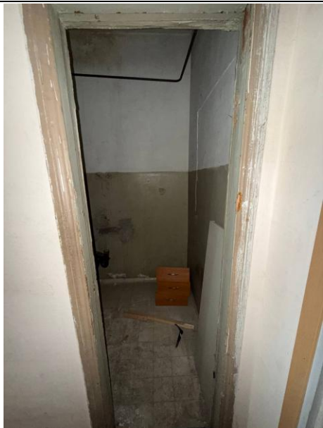
Фото № 9 – Внутреннее состояние помещения
