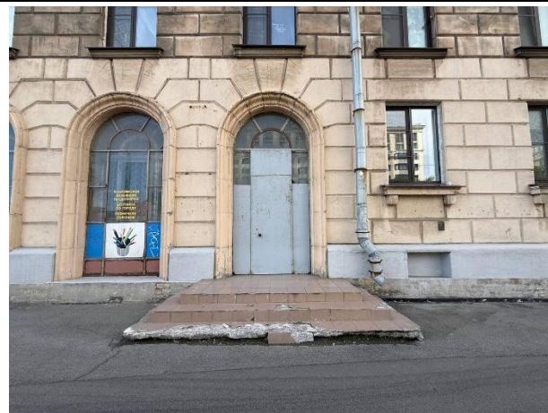
Фото № 4 – Вход в помещение
