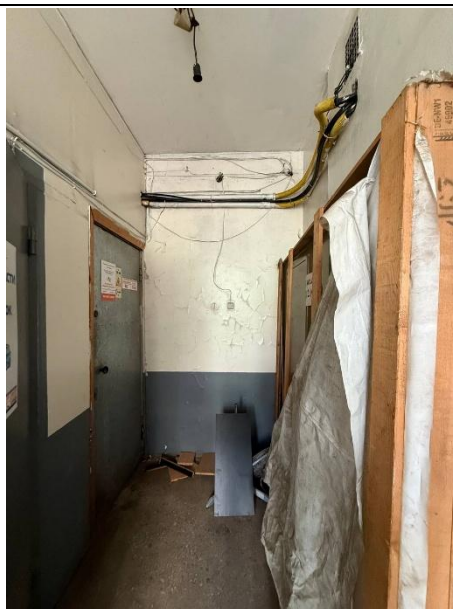
Фото № 6 – Внутреннее состояние помещения
