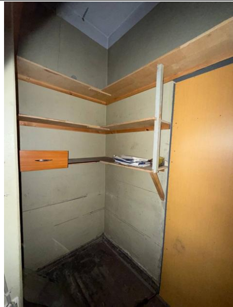
Фото № 12 – Внутреннее состояние помещения
