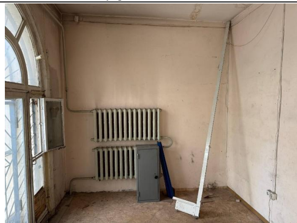
Фото № 8 – Внутреннее состояние помещения
