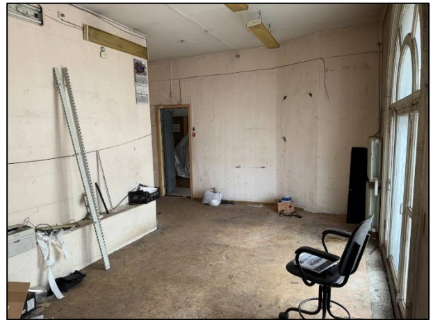
Фото № 14 – Внутреннее состояние помещения
