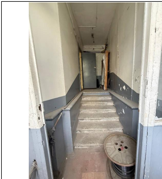
Фото № 5 – Внутреннее состояние помещения
