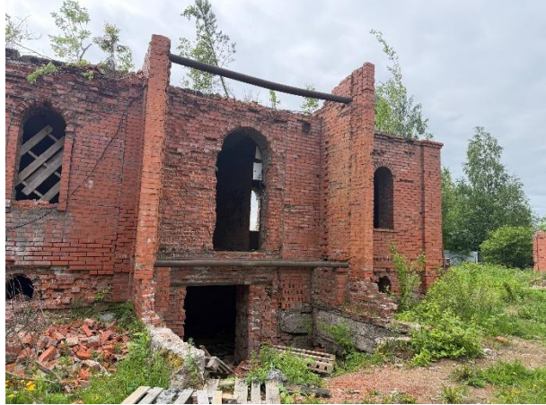
Фото № 13. Внутреннее состояние здания
