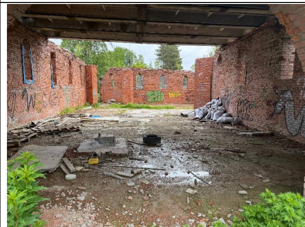
Фото № 9. Внутреннее состояние здания
