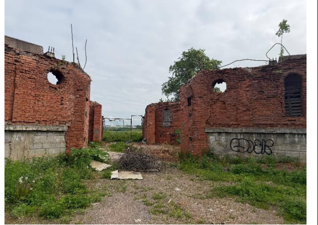
Фото № 14. Внутреннее состояние здания
