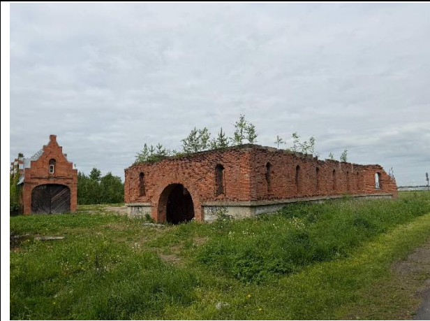
Фото № 5. Внешний вид здания
