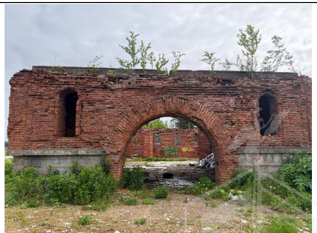
Фото № 10. Внутреннее состояние здания
