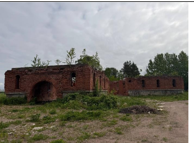
Фото № 8. Внешний вид здания
