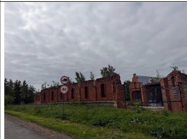
Фото № 7. Внешний вид здания
