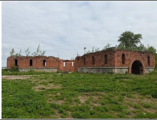
Фото № 11. Внутреннее состояние здания
