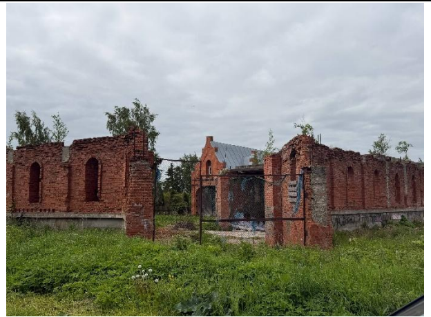
Фото № 6. Внешний вид здания
