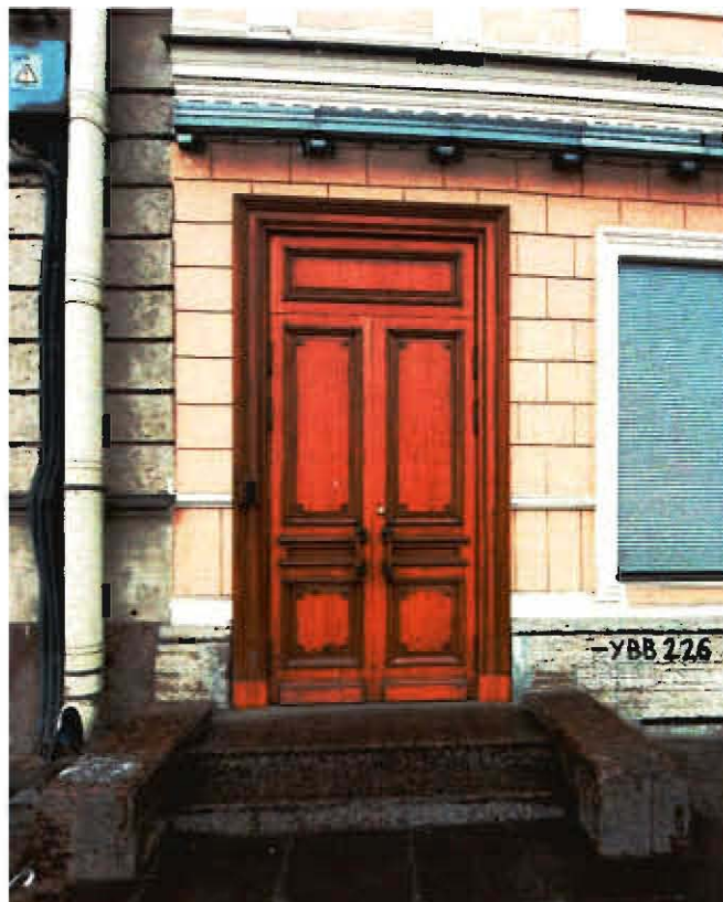
Фото 3. Входная группа (лицевой фасад по Английской набережной). Деревянный (дубовый) портал. Крыльцо из двух гранитных ступеней с глухими гранитными подпорными стенками. Фото выполнено 13.03.2025.
