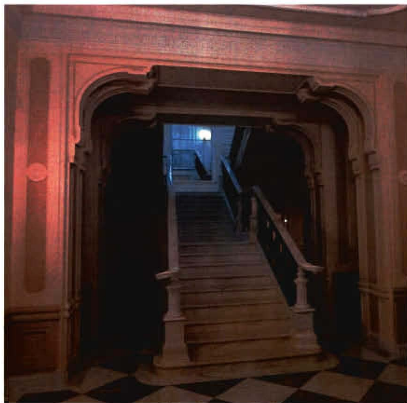
Фото 27. Лестница 6-ЛК. Фото выполнено 23.06.2025.
