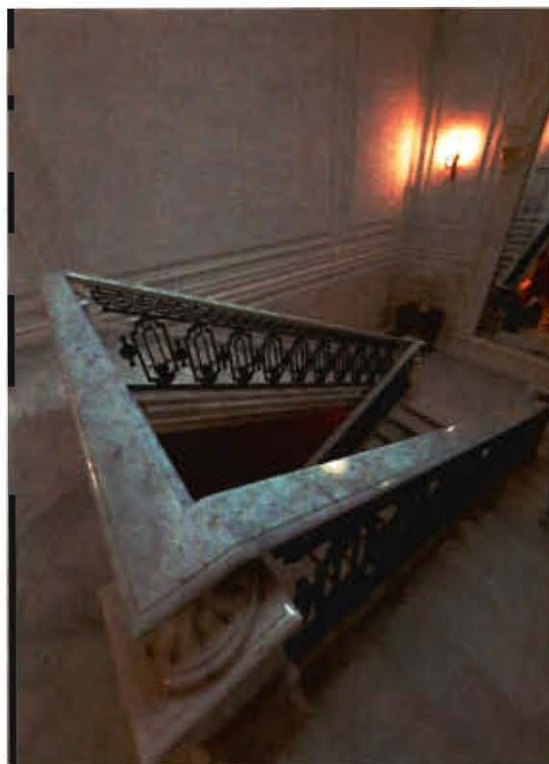
Фото 29. Лестница 6-ЛК. Фото выполнено 23.06.2025.
