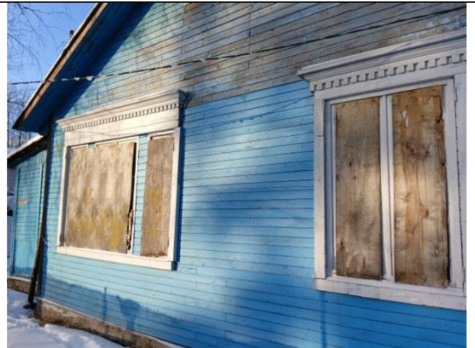
Фото 6. Вид на здание размещения Объекта оценки.
