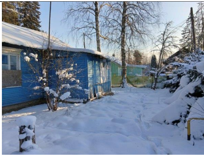
Фото 3. Вид на здание размещения Объекта оценки.
