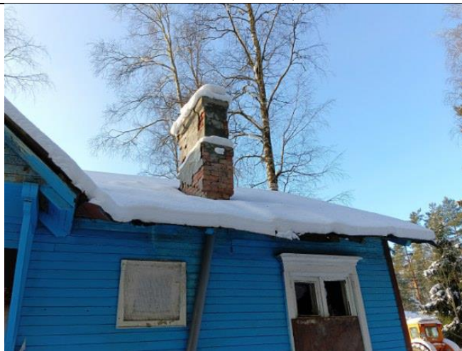
Фото 7. Вид на здание размещения Объекта оценки.
