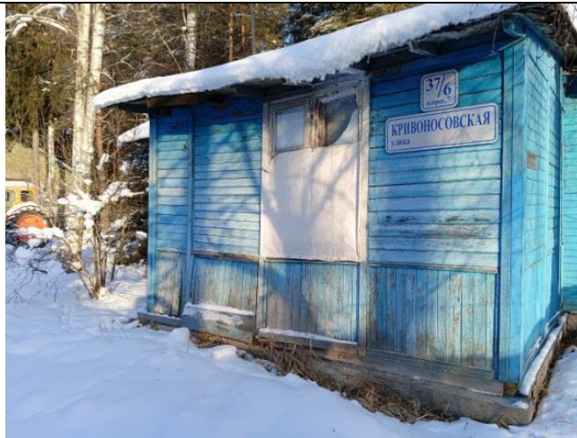
Фото 5. Адресная табличка на здании Объекта оценки.
